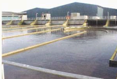
Grootonderhoud aan een waterzuiveringsinstallatie is geschikt voor projectmatige aanpak
