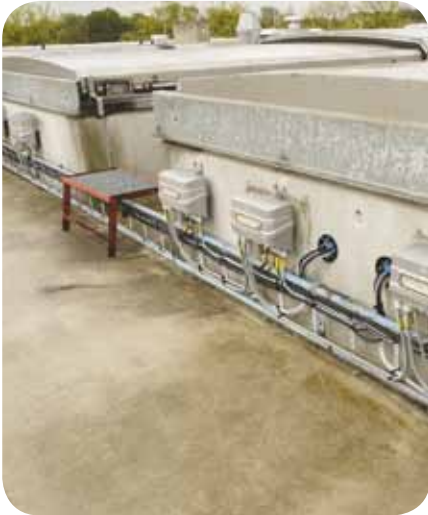
Twee vlokvormers met aan de buitenzijde geplaatste SEW-frequentieomvormers voor de aandrijving van de roerwerken. Rechts: Bij Evides is PROFIBUS nu de standaard.
