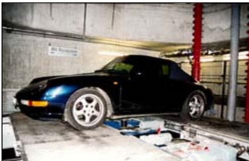
Figuur 3. Automatische parkeergarage van de firma's CVSS en JB Systems
