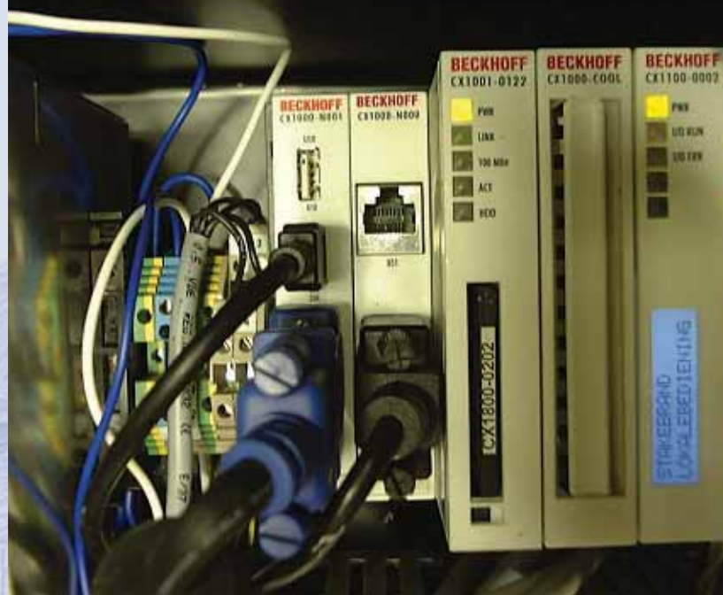
De CX-1000 speelt een grote rol bij de besturing in Carré. Deze Beckhoff-IPC's worden gebruikt voor de liertrommelaandrijvingen en als PLC bij de takels
